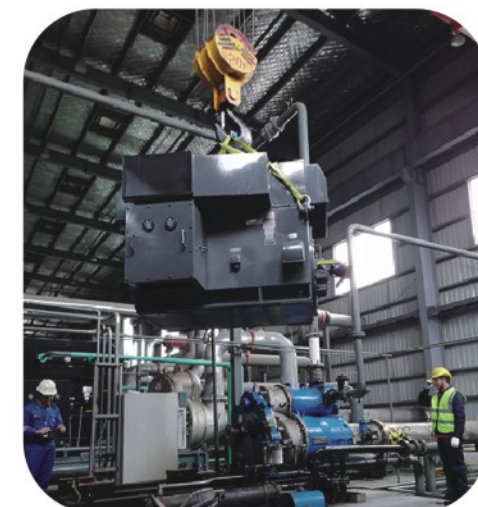
▲ 大型工业气体公司安装试车
