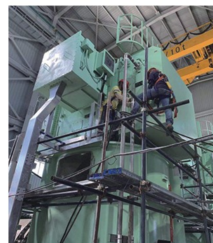
▲ 立式马达现场安装、调试
