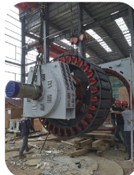
▲ 广东韶关某铅锌矿同步机安装
