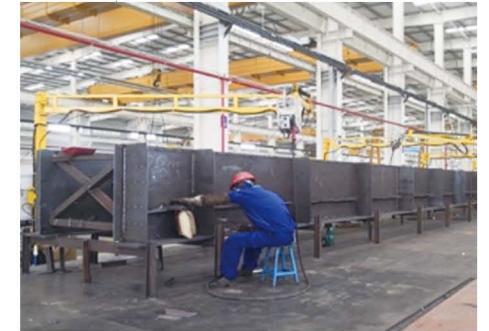
Install longitudinal stiffeners
